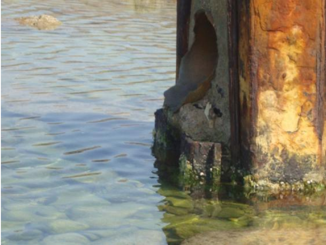
شكل (1.4): أنبوب الصرف الصحي الموجود بمنطقة الصابري.
