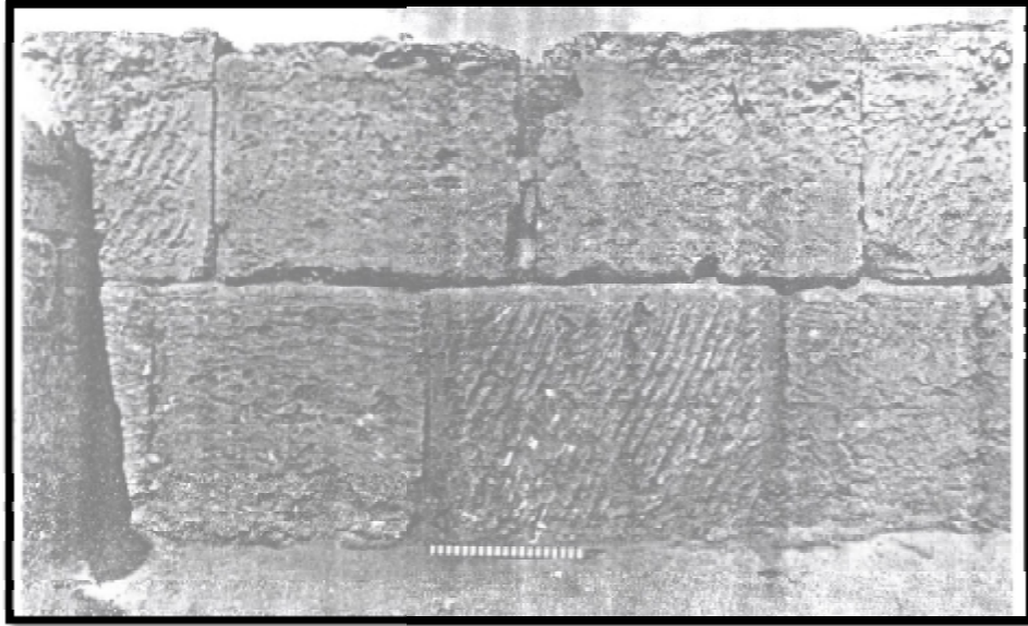
صورة (57): الحزوز القطرية على بعض الكتل الحجرية لمبنى الجناح الشرقي في الحمامات البيزنطية غير المستكملة
