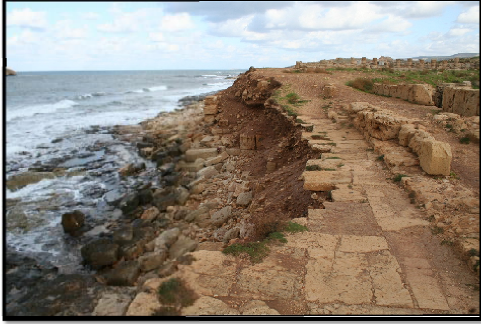
صورة (7): إنهيار حجارة رصف شارع الديكاماتوس بسبب الأمواج تصوير الباحث
