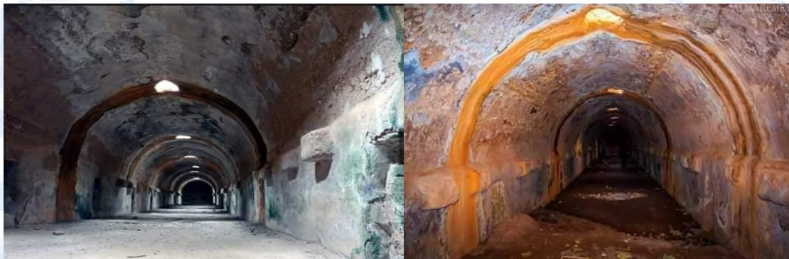
صورة (15) صهاريج المياه
