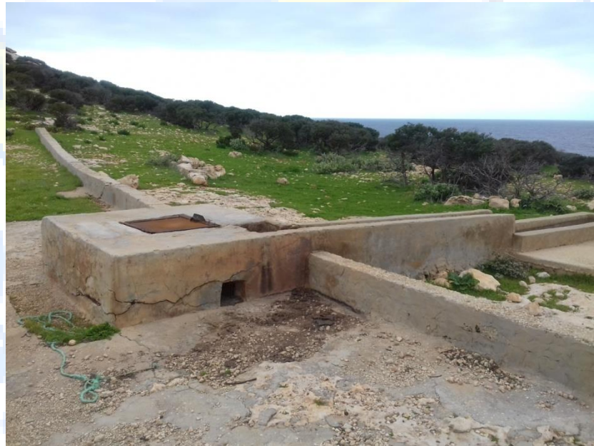
شكل (18) صهريج تجميع مياه منحوت في الأرض الصخرية شرق المستوطنة لا يزال مستخدم إلى الآن . (تصوير الباحث)
