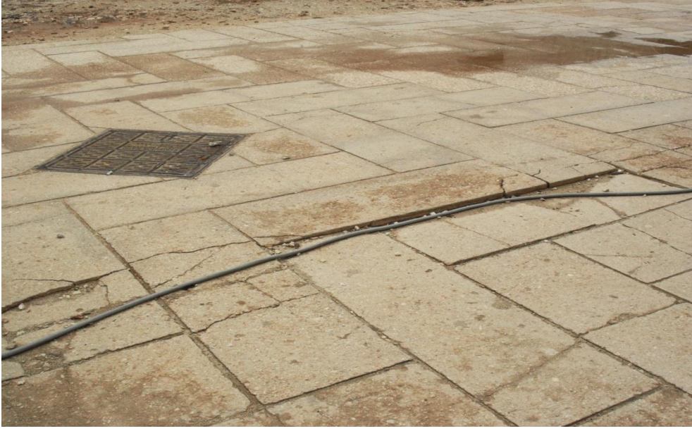
صورة ( 11.2 ) تكسر و هبوط رصيف المشاة (كلية الاقتصاد ، المكتبة المركزية)
