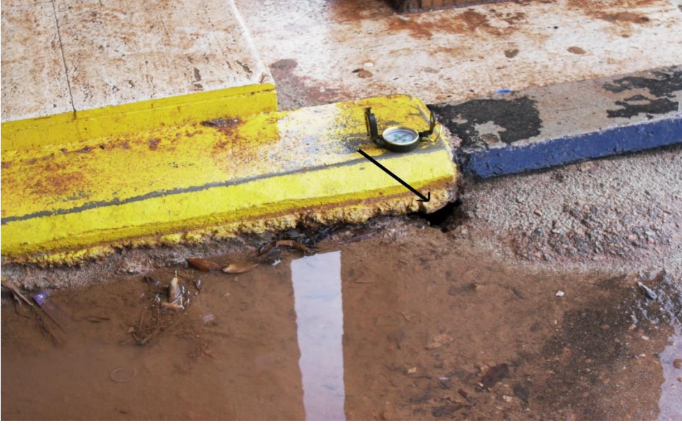
الصّورة ( 18.2 ) تجويف مصاحب لعملية هبوط الطريق الإسفلتي بجامعة بنغازي
