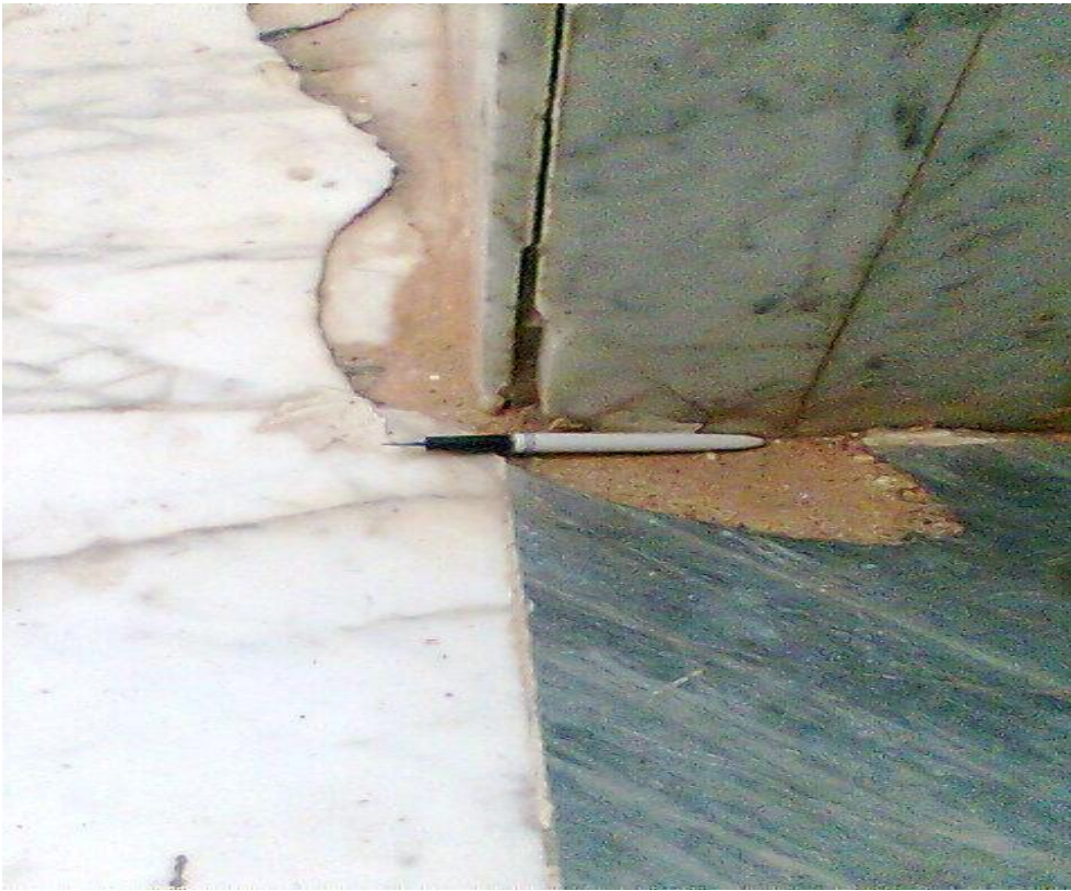
الصورة ( 10.2 ) تكسر البلاط حول أعمدة المكتبة المركزية-جامعة بنغازي
