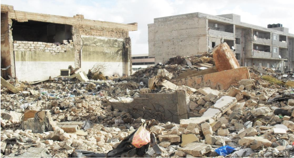
صورة ( 8.2 ) هدم سقف المبنى في الصورة السابقة مع تضرر في أحد حوائط المبنى المجاور
