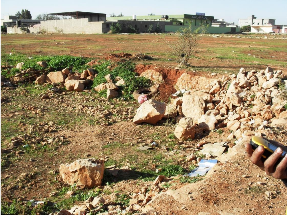
الملحق (3) حفرة هبوط - بو عطني
