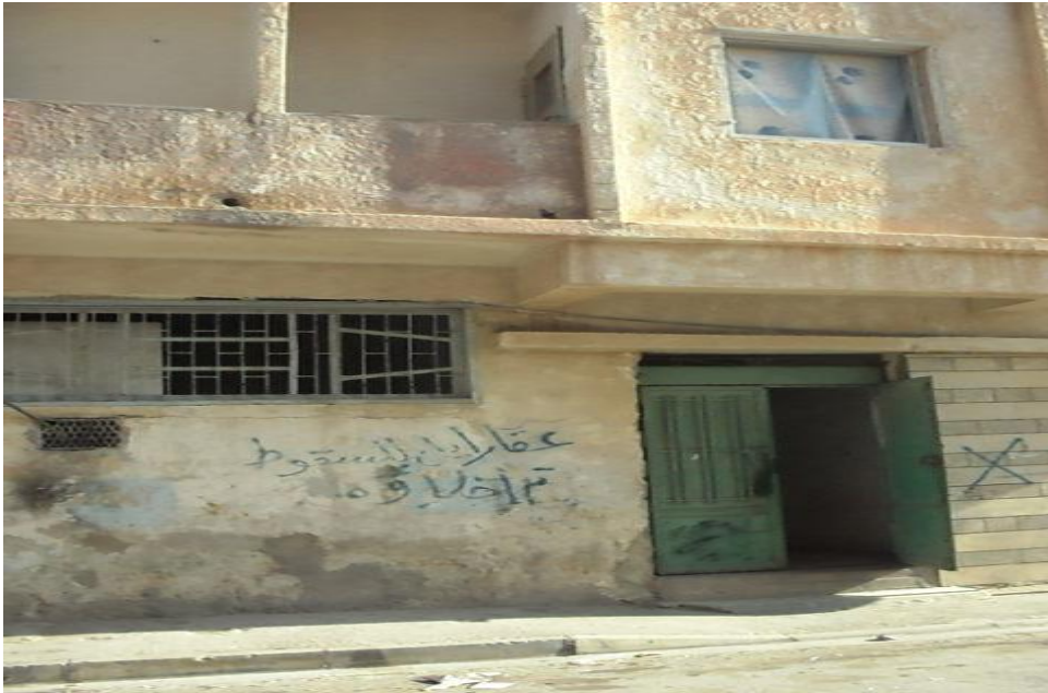
الصورة (28.4) مبنى مكتوب عليه عبارة عقار آيل للسقوط تم إخلاءه ومازلت تسكنه عائلة.
