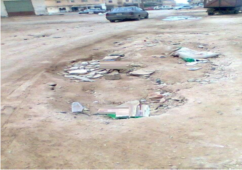
الصورة ( 16.2 ) هبوط ضحل في إحدى الطرق قبل رصفها
