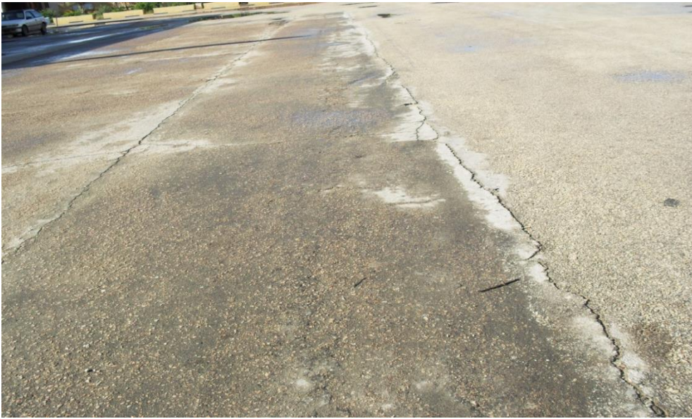
الصورة ( 17.2 ) تكوّن شقوق طولية في موقف سيارات جامعة بنغازي
