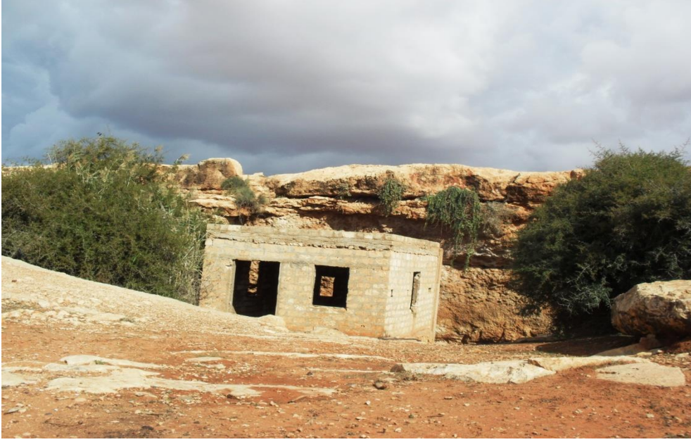
الصورة (9.2) ميلان غرفة في قاع هوى شق الغراب بعد بنائها بقليل
