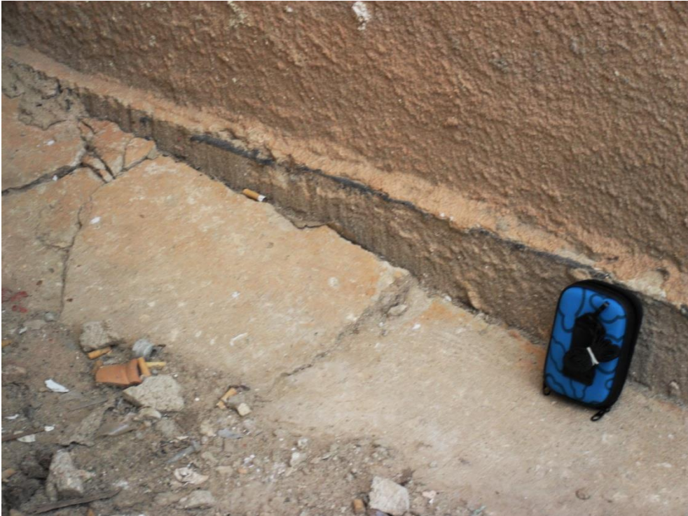
صورة ( 14.2 ) تكسر و هبوط في الرصيف الخارجي المصاحب لعملية الهبوط
