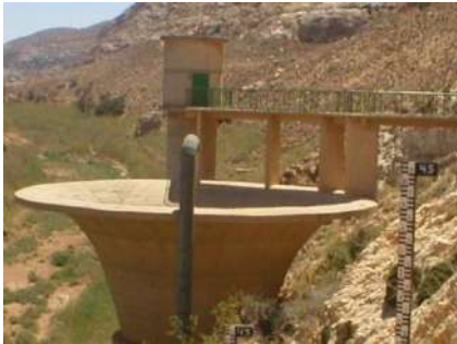
مفيض السد (spillway)
