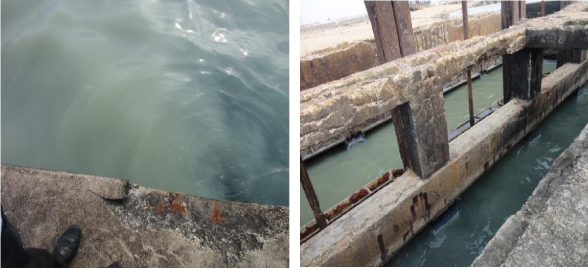
شكل (47-48) قناة تصريف لمياه الصرف الصحي خلف النادي الأهلي بنغازي
