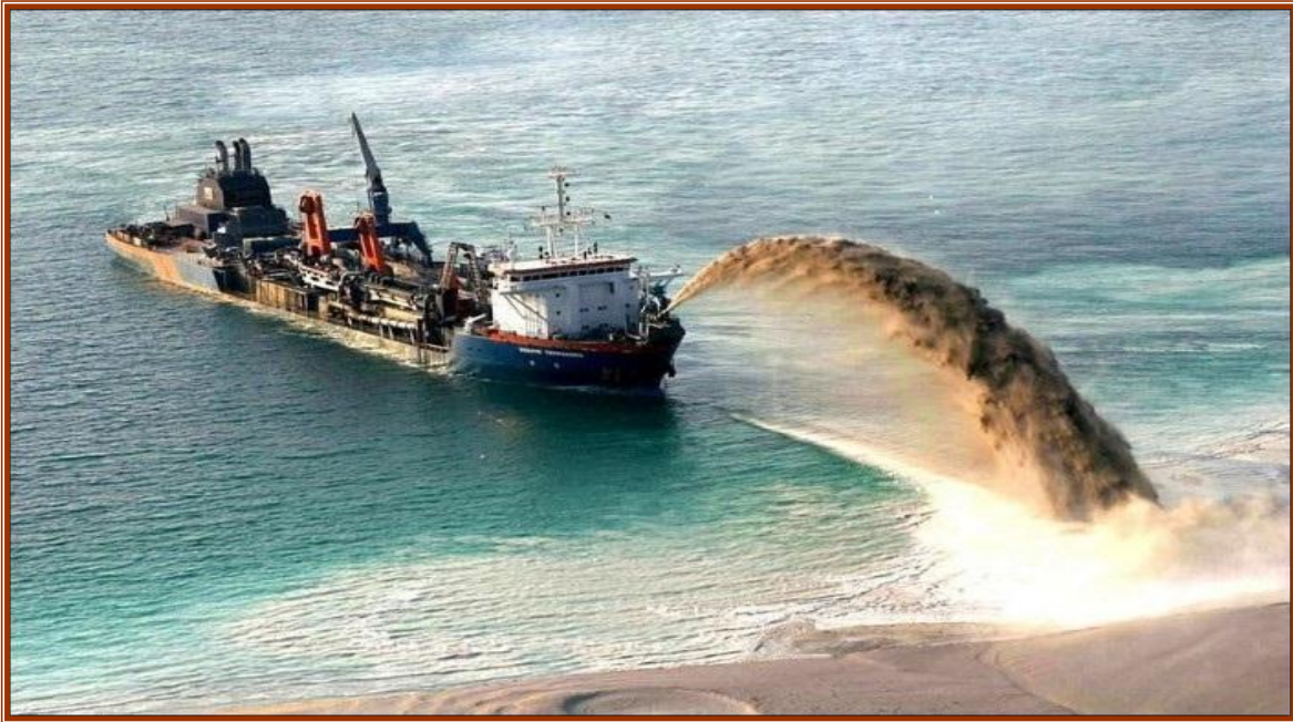
شكل (76) كيف يتم بناء جزيرة نخلة الجمير الاصطناعية بدويي
