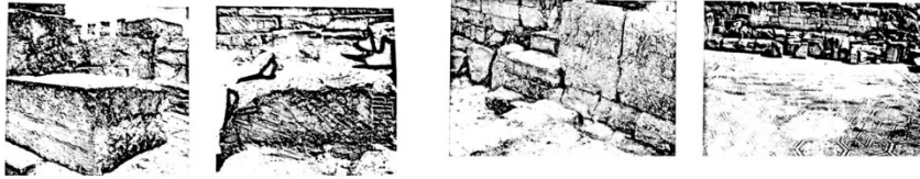
وصل الكتل باستخدام الرصاص المصهور
