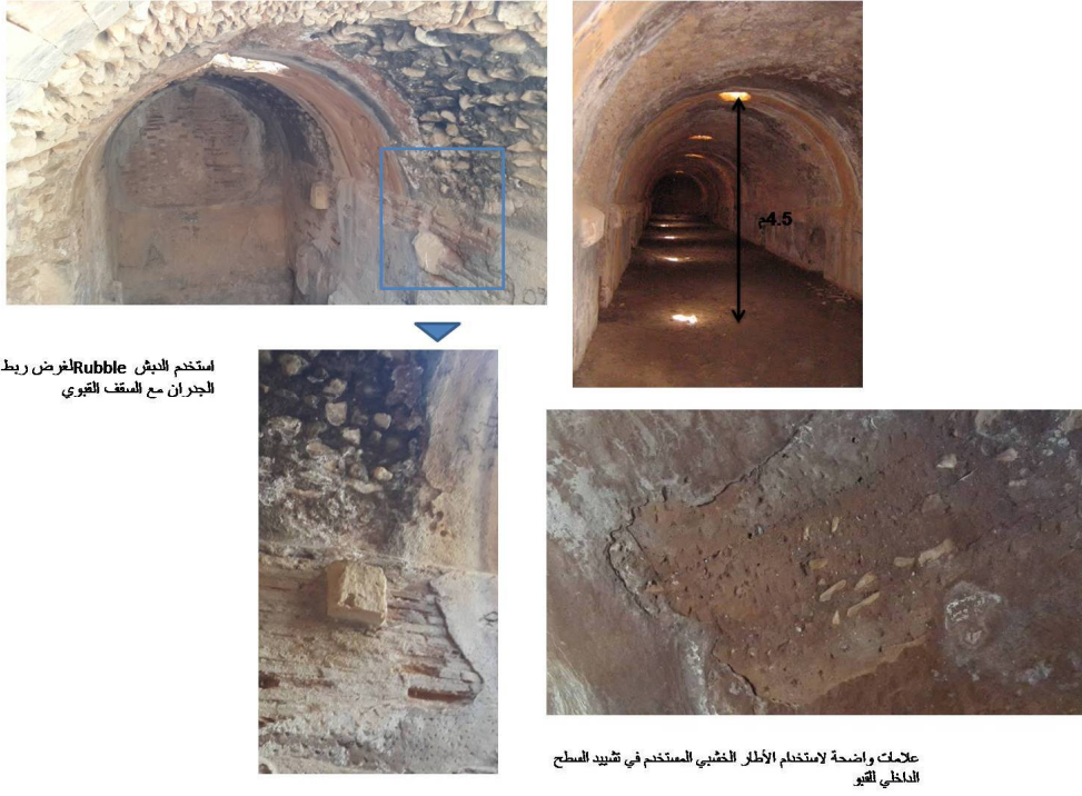
(الشكل 292): يوضح بعض تفاصيل السقف القبوي في مناطق مختلفة من الصهرج
