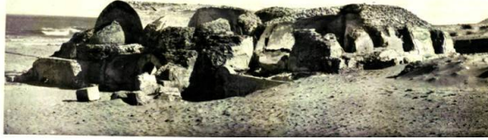
مبنى الحمامات من الجهة الجنوبية الغربية
