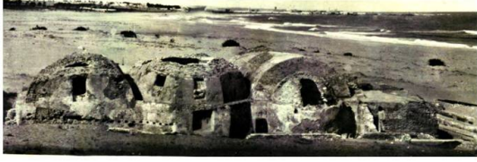
مبنى الحمامات من الجهة الشرقية
