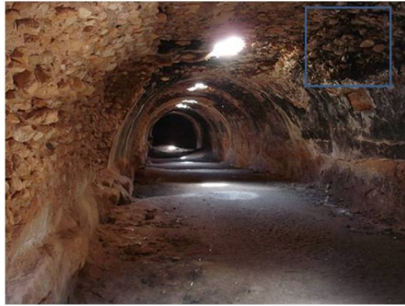
استخدام أسلوب البناء Opus Caementium في بناء السقف البريدي
