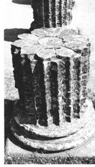
القطع الحجرية تكون شكل الزهرة مع الجزء المركزي للعمود
