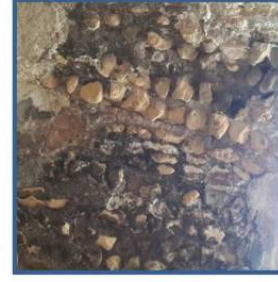
طبقة الجص الخارجية التي تغطي السطح الخارجي للسقف
