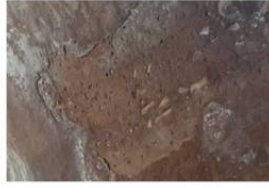
طبقة الجص الخارجية التي تغطي السطح الخارجي للسقف
