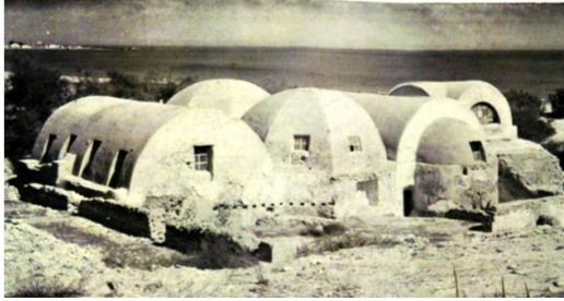
صور لمبنى الحمامات من الجهة الجنوبية الشرقية
