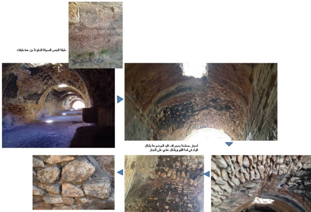
(الشكل 293): يوضح استخدام المونة المخلوطة مع الدبش المكونة من الأحجار الموجودة في الموقع في بناء السقف
