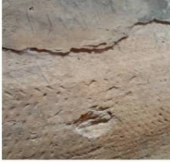
طبقة الجص الخارجية التي تغطي السطح الخارجي للجدران الداخلية
